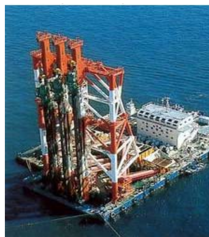
Hình 1.b: Thiết bị thi công SCP dưới nước
