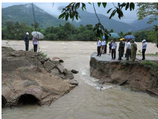
Hình 3a: Đường bộ đoạn qua Vĩnh Thạnh, Bình Định bị vỡ đứt do mưa lũ 2016 Nguồn: Báo Bình Định
