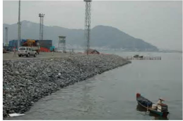
Hình 6: Hình ảnh kè bãi sau khi thi công xong
