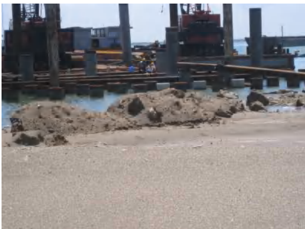
Hình 3: Hệ sàn đạo đóng cọc BTCT DUL và đóng cừ thép
