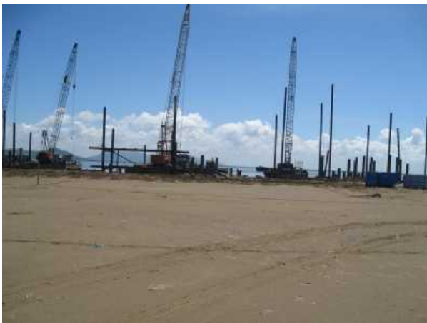
Hình 1: Thi công đóng cọc BTCT DUL
