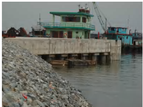
Hình 4: Hình ảnh mặt bên hông của gằm bên sau khi thi công xong
