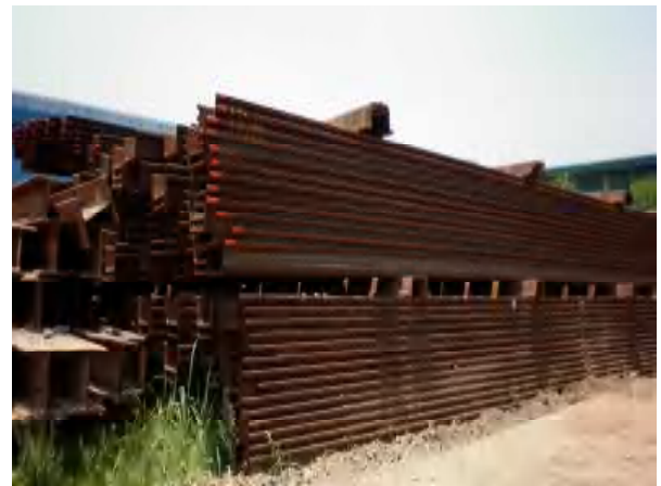
Hình 2: Tập kết cừ thép tại công trường
